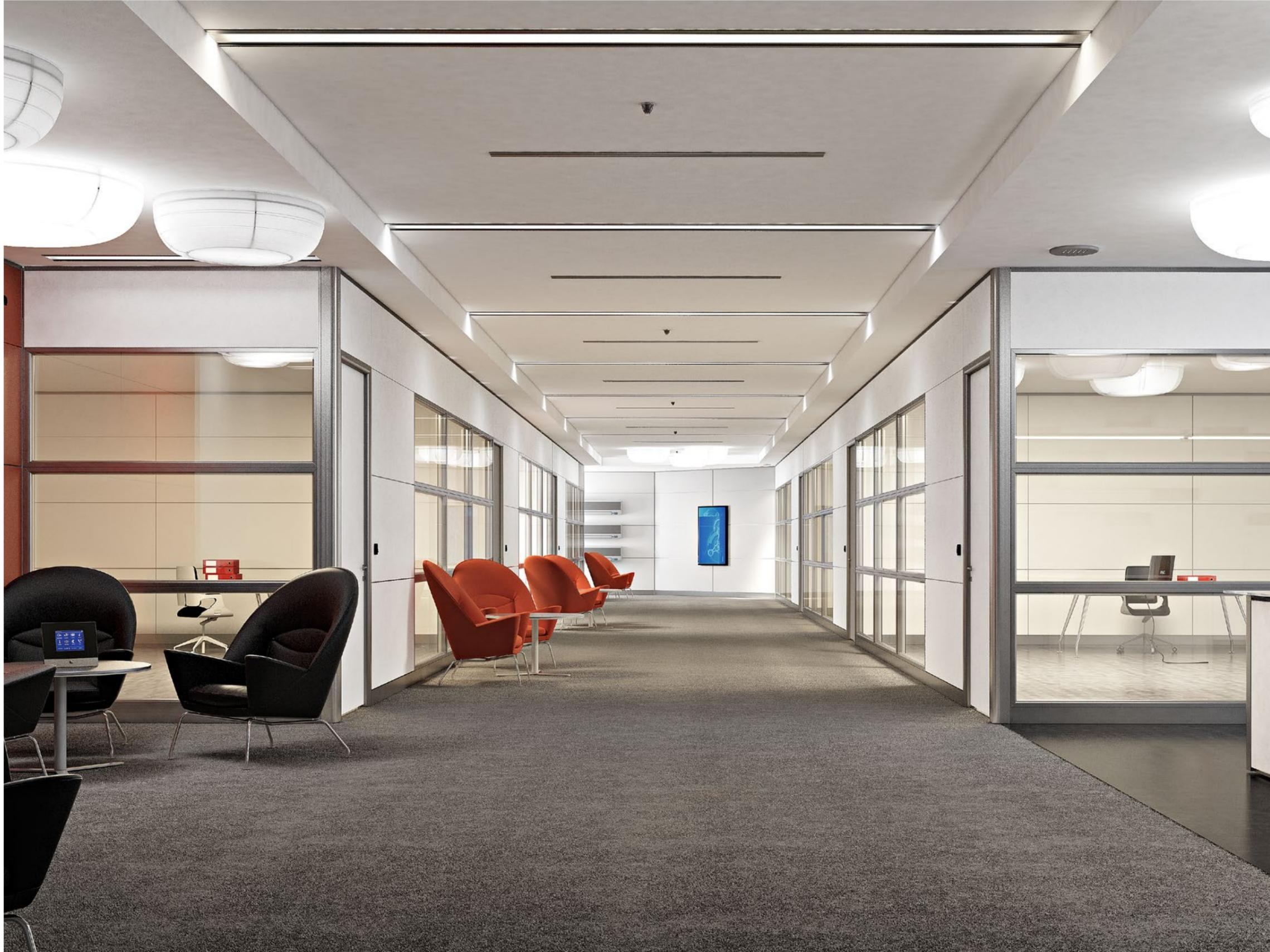
Nella foto, la parete Wall System 1 con moduli in vetro doppio ad effetto orizzontale. Porte cieche con serratura magnetica. I moduli divisori ciechi permettono la canalizzazione e la disposizione degli interruttori.
